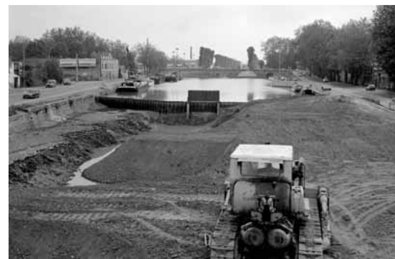
Travaux de modification du bassin de l'Embouchure et disparition des écluses de descente en Garonne, pour construire l'échangeur des Ponts-Jumeaux de la rocade ouest - juin 1978. (Archives municipales de Toulouse)
